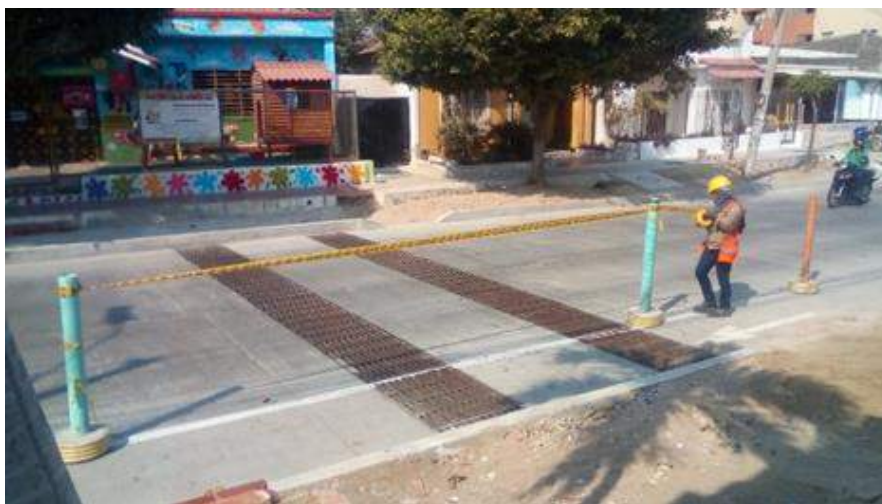
Sumideros transversales construidos en la captación de la carrera 50 con la calle 62.
