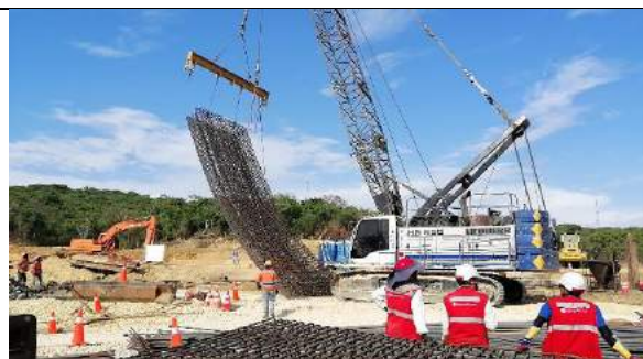
Izaje de la canasta de acero de refuerzo de los muros pantalla.
