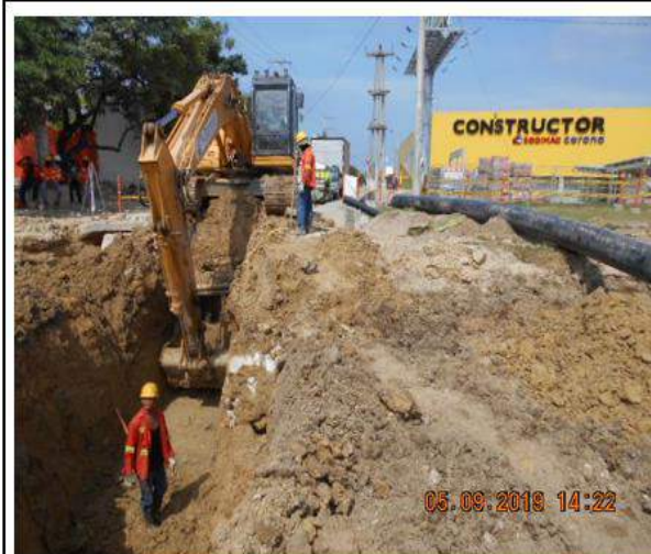
Foto 5. Excavación para instalación de tubería PEAD de 14" transversal a la calle 30 en Carreras 10 calzada oriental.
