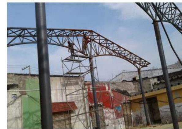
FOTO 4 Pintura anticorrosiva de la primer cuerpo de cercha y columnas - Mercado EPM.
