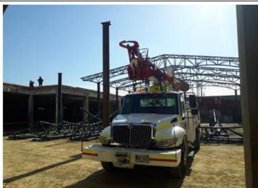
FOTO 1 Proceso de montajes cuerpos de cercha y columnas - Mercado EPM.
