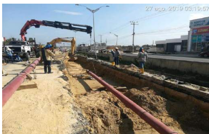
izaje e instalación de tubería de \phi 10'' de Promigas
