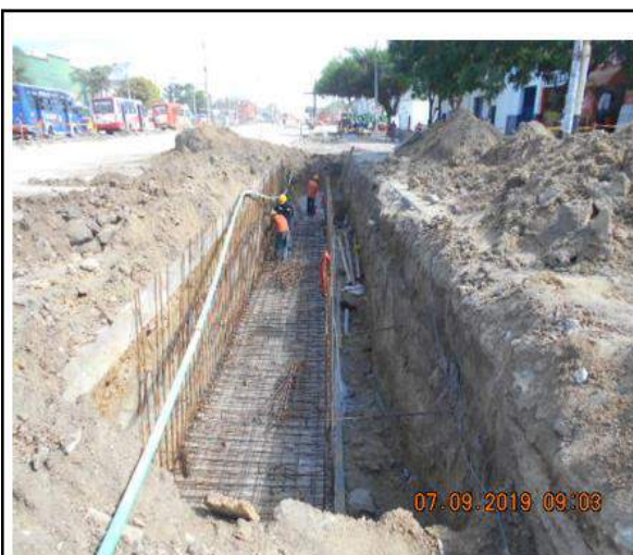
Foto 3. Armado de refuerzo para Losa Inferior de Box Culvert longitudinal en la calle 30 entre carreras 10 y 15, costado oriental.
