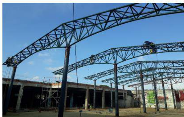
FOTO 2 Pulida cordón de soldadura cerchas instaladas-Mercado EPM
