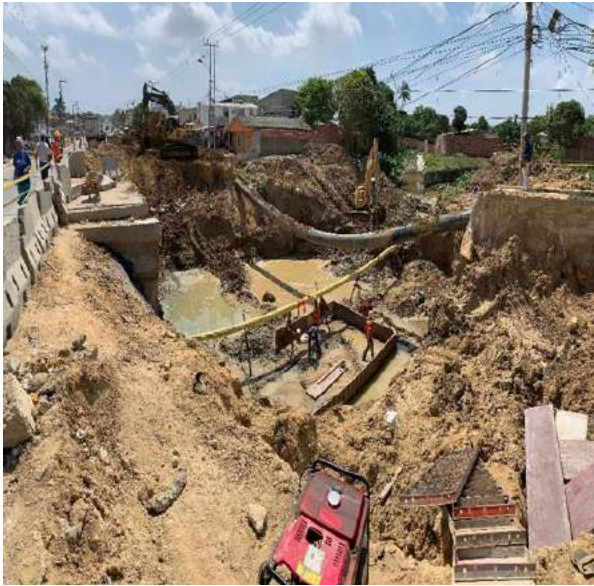
Armado de formaleta para zapata de la segunda etapa del pontón Santo Domingo
