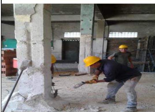
FOTO 5 Demolición camisa columnas Zona Mezzanine - Mercado EPM
