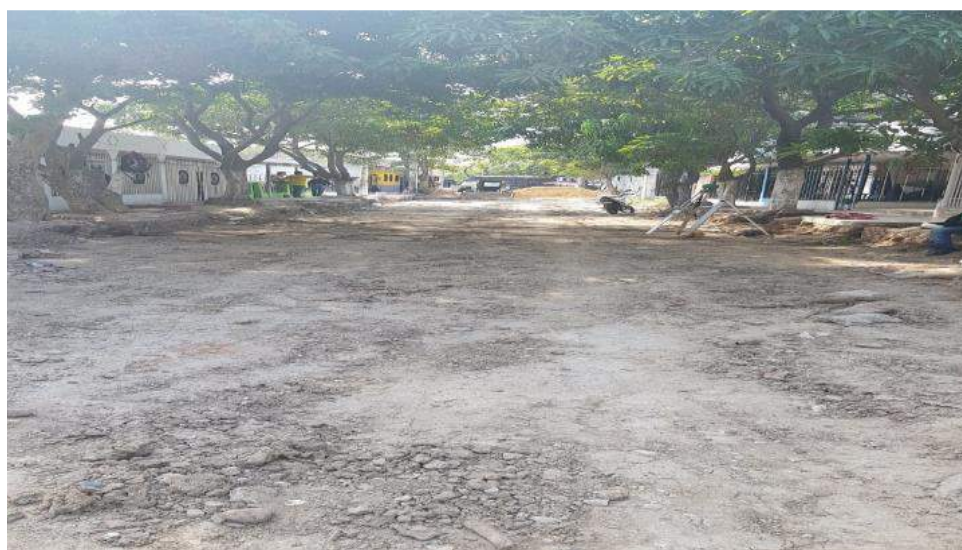
NIVELACIÓN DE TERRENO PARA SUELO CEMENTO
