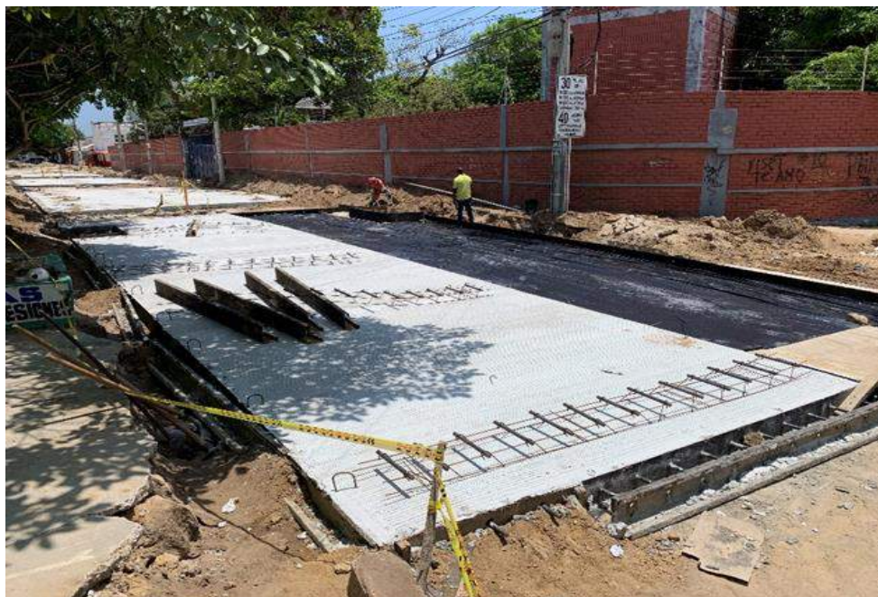
Losa de pavimento fundida en la calle 53 D entre carreras 21 y 21A
