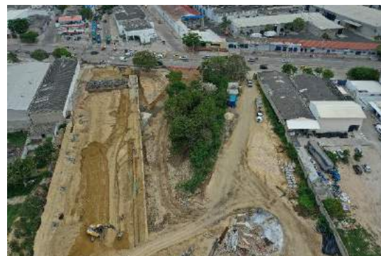
Construcción de Carcamos inicio calle 72, construcción de Box auxiliar. Rellenos. Empalme calle 72 y vía 40.
