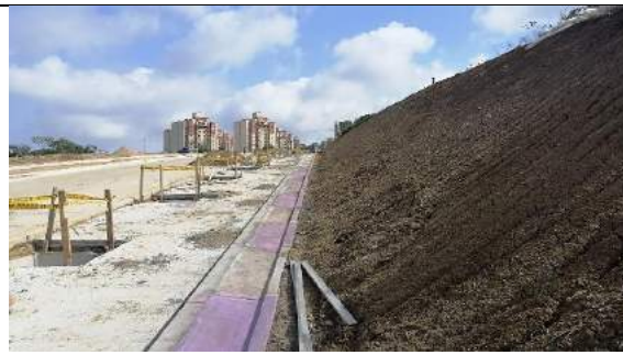
Construcción de cunetas al pie de taludes.
