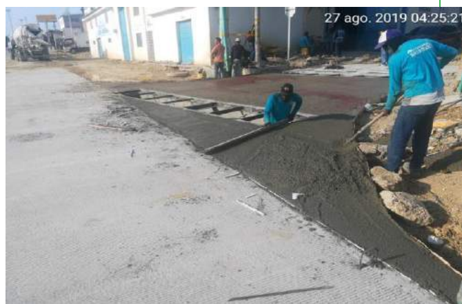
Pavimento rígido calzada empalme con calzada de servicio
