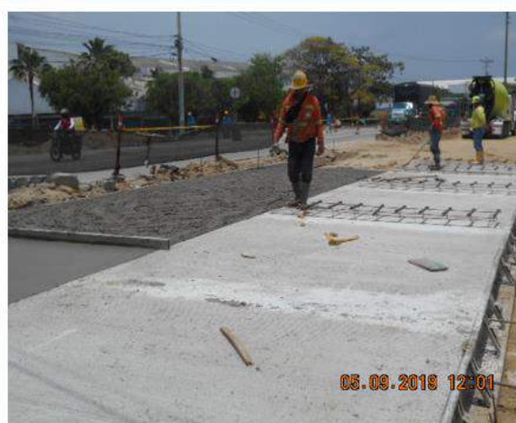
Foto 2. Fundida de Carril #1 de Pavimento Concreto MR-45 en la calle 30 entre carreras 15 y 18, calzada oriental.
