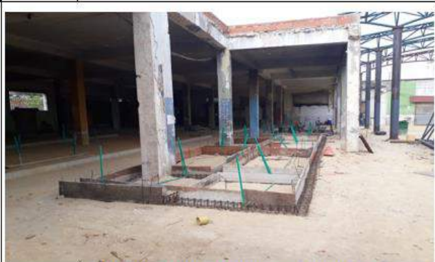
FOTO 10 Formateada de viga de cemento de los módulos con el entubado para instalaciones electricas
