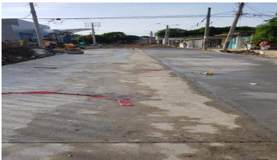
INSTALACIÓN DE CONCRETO MR EN CALLE 46A ENTRE 6 SUR Y 3 SUR
