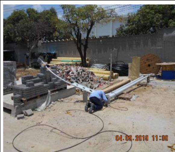
Foto 6. Instalación de postes de iluminación en costado occidental de la Calle 30 entre carreras 11 y 13C.
