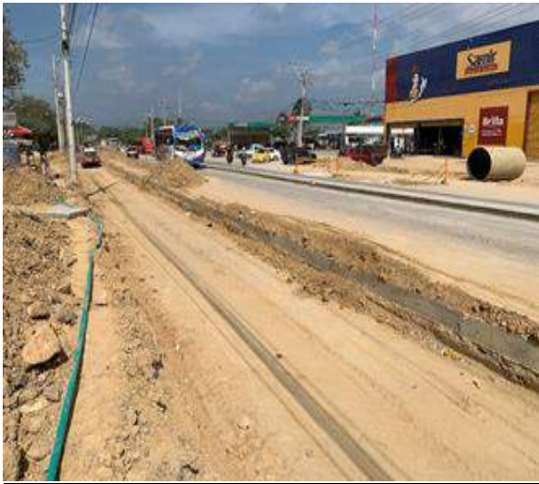
Conformación del carril externo, lado derecho en la carrera 6 con calle 99 B
