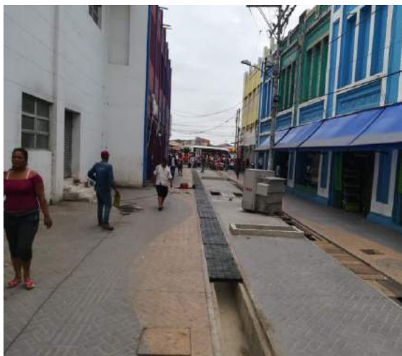
INSTALACION DE 40 MI DE REJILLA LONGITUDINAL ENTRE LAS ABS K0+080 A K0+040 LADO IZQ, UBICADA EN CRA 42 ENTRE 30 Y 31.
