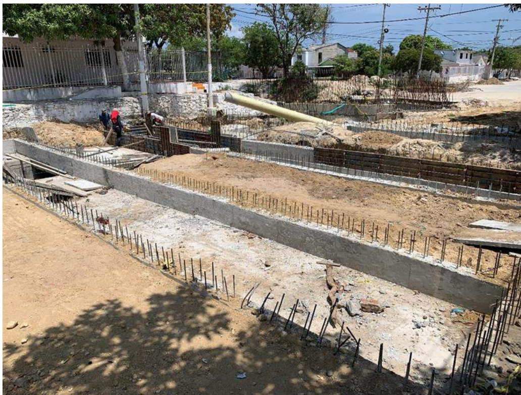
Fundida de muros para captación de aguas lluvias en la calle 40 con carrera 13 C
