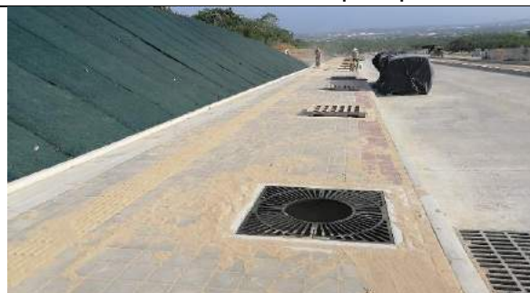
Rejillas para alcorques y manto de protección de taludes.
