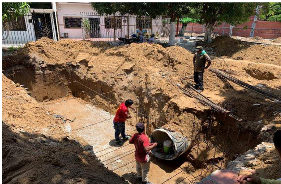
Refuerzo para cárcamo ubicado en la carrera 21 A con calle 53 D
