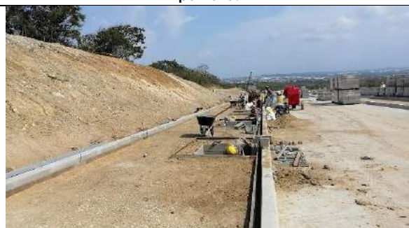
Instalación de bordillos prefabricados para espacio público. Construcción de alcorques.
