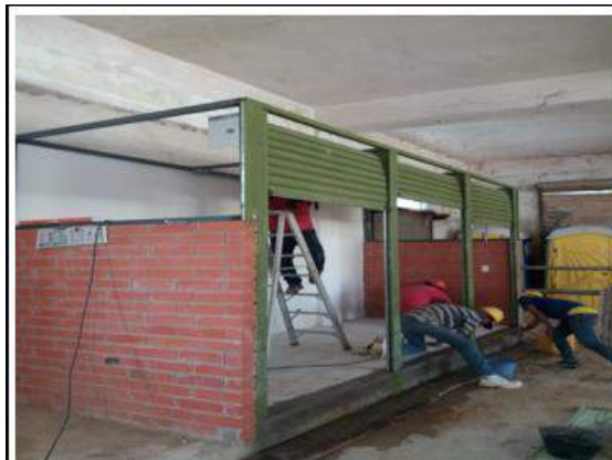
FOTO 11 Proceso constructivo de modulos comerciales con diferencia de nivel con respecto de las areas de circulación de publico.
