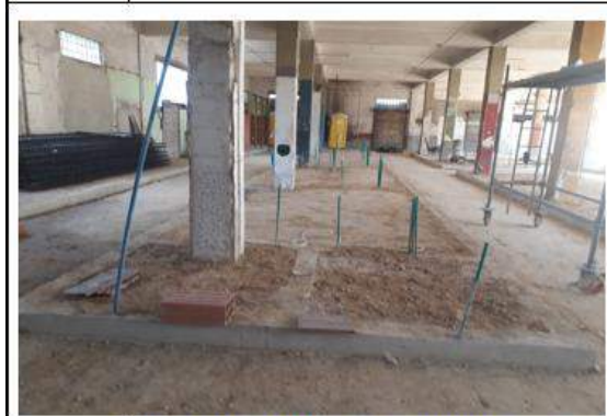
FOTO 9 Vista de viga de cemento de los módulos con el entubado para instalaciones electricas
