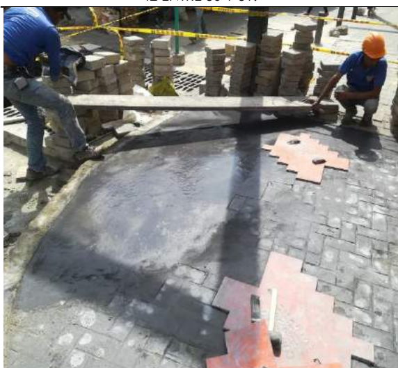
FUNDIDA DE PAVIMENTO ESTAMPADO EN ANDEN UBICADO SOBRE LA CRA 42 ENTRE 32 Y 31
