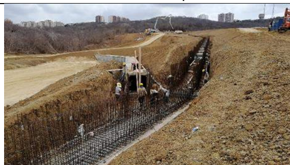
Empalme del Box No 3 con el Canal Central escalonado
