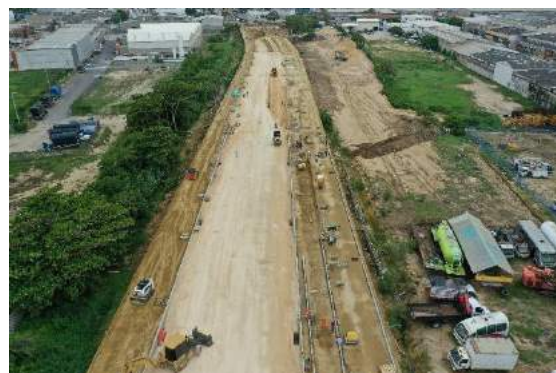
Construcción suelo cemento, redes e instalación de bordillos y sardineles. En vía calle 72
