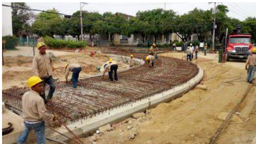
Armado del refuerzo de la placa superior en la curva de la carrera 53 con calle 61.
