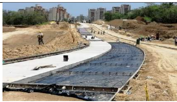
Fundida de pavimento en la calzada de salida
