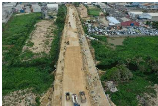
Construcción de base. Instalación de adoquines en anden izquierdo.
