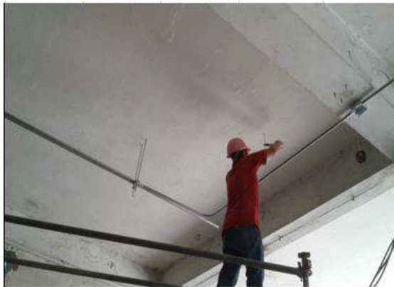
FOTO 7 Instalación tubería (galvanizada) con cajas para
