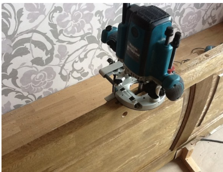
Рисунок 1 – Вырезание углубления под установку фурнитуры в «ручном» режиме в полотне двери с помощью ручного фрезера. Полотно двери установлено и зафиксировано вертикально.
